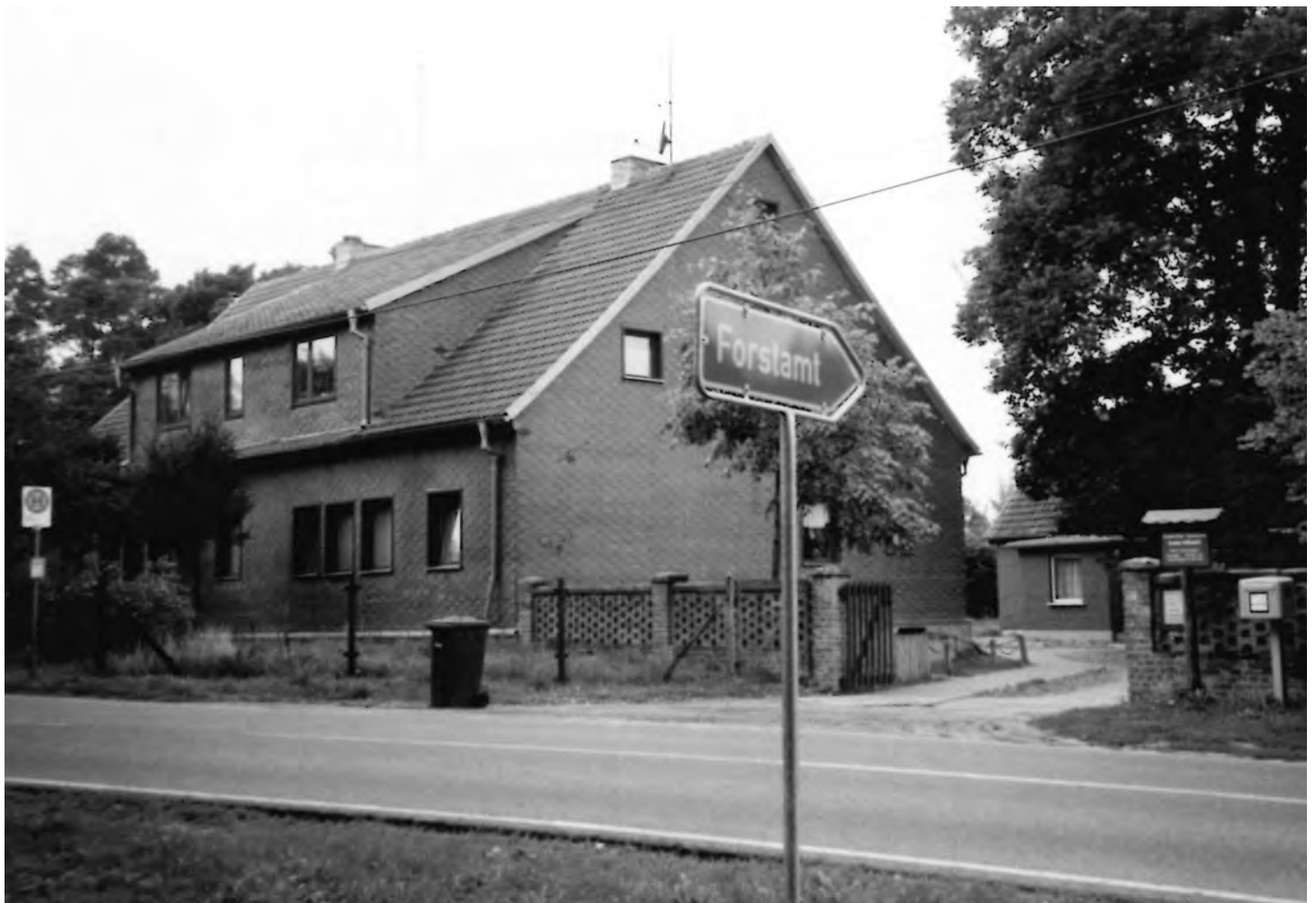
Forstamt-Wohnhaus; im Vordergrund die Torgelower Straße
